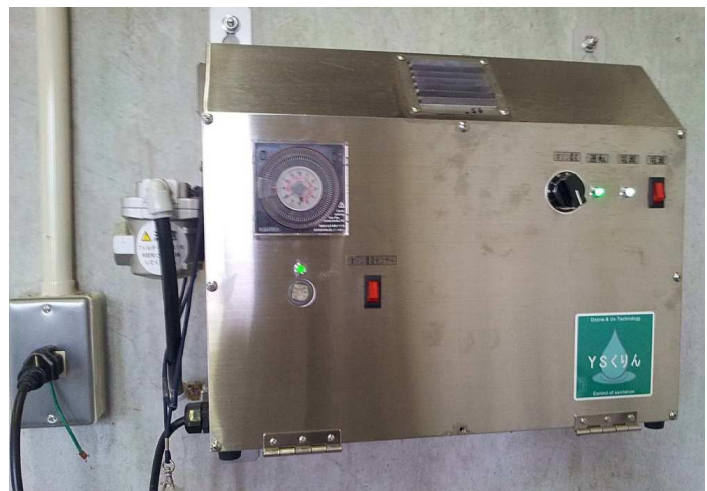
換気扇にオゾンガスを吸引させる方式(YS1000-OZSF)
