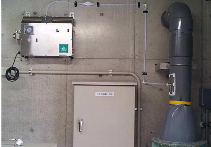
排気管にオゾンガスを注入する方式(YS1000-OZF-T)
