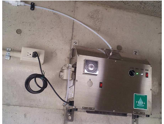
排気管にオゾンガスを注入する方式(YS1000-OZF-T)
