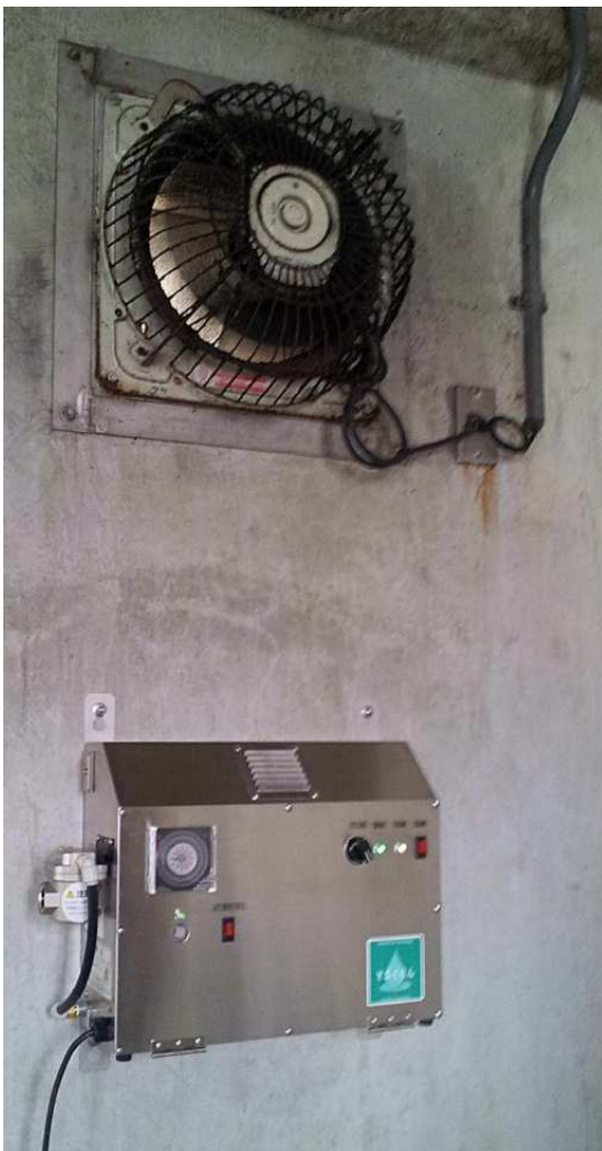
換気扇にオゾンガスを吸引させる方式(YS1000-OZSF)
